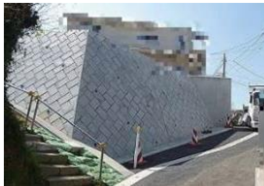
改善後（間知ブロック石積擁壁）
